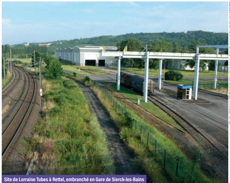
Site de Lorraine Tubes à Rettel, embranché en Gare de Sierck-les-Bains
